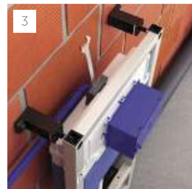
3 Подсоедините инсталляцию к водоснабжению и сливу. Установите защитные короба.
